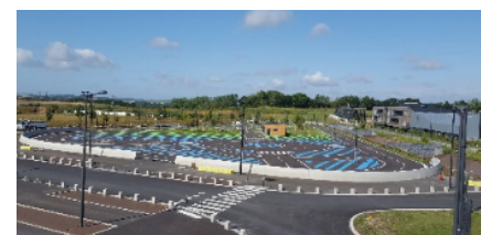
Piste d'essais instrumentée et de démonstration GYROVIA (CAVM/UPHF)
