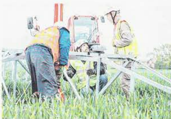
RTE (Réseau de transport d'électricité) veille sur le réseau électrique régional. Ici, le remplacement d'un pylône. REPRO « LA VOIX »
